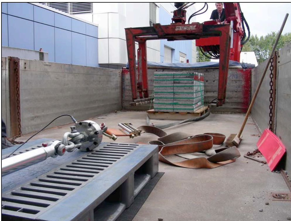
Bild 2: Klammeregreifer am fahrzeuggebundenen Kran zur Be- und Entladung von paketierten Betonwaren
