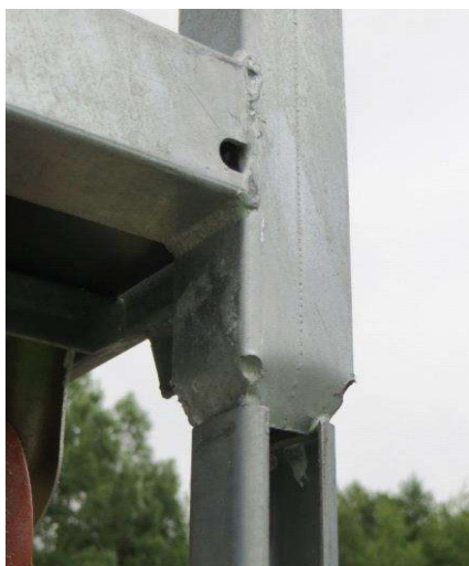
Bild 10 (links): Unsichere Verbindung beim Stapeln von CC-Containern
